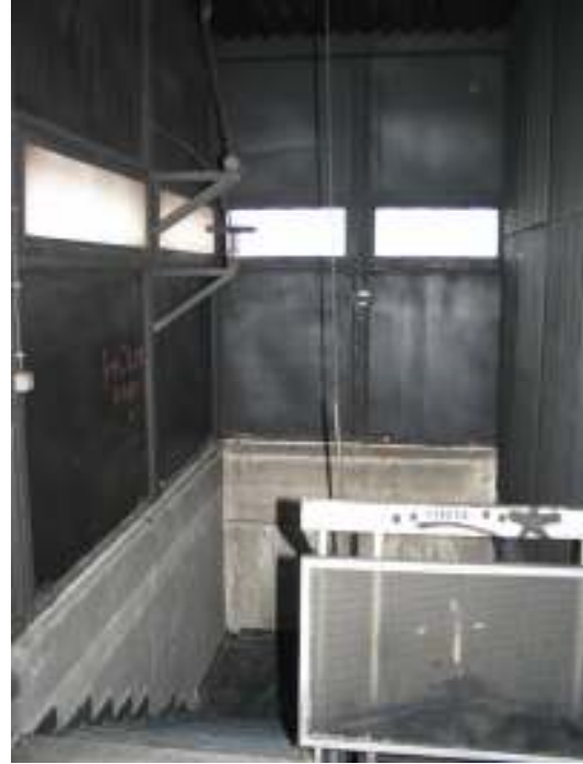
12 sz. kép. A lépcsőház legfelső szintje, balra a gravitációs hő- és füstelvezető nyílással és annak üzemképtelen működtető mechanizmusával (fotó: Takács Lajos Gábor)
