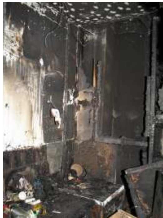
10 sz. kép. A VIII. emeleti lakás konyhájának belső képe. Itt jól megfigyelhető, hogy a tűzhely eredeti helyén található és az akna – nagyszámú megsemmisült - favázas farostlemez burkolata is még eredeti (fotó: Takács Lajos Gábor)
