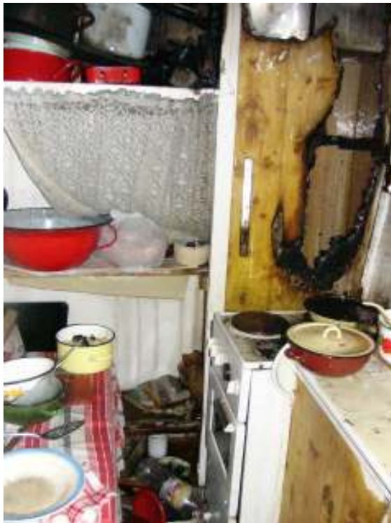
6 sz. kép. A Fényesudvar 6. sz. alatti lépcsőház földszint 2 sz. lakás konyhája a tűzhellyel és a szagelszívó akna éghető burkolatával, amely elsőként gyulladt meg (fotó: Debreceni Hivatásos Önkormányzati Tűzoltóparancsnokság)
