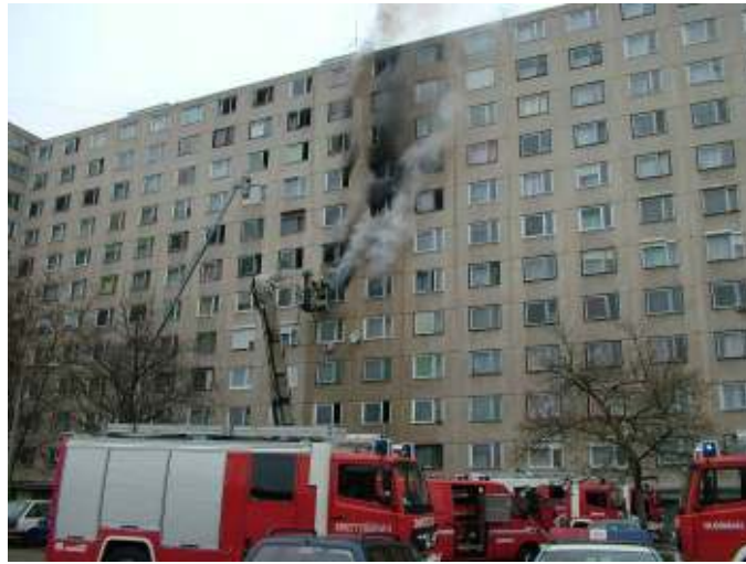
5 sz. kép. A déli homlokzat összképe tűzoltás közben (fotó: Debreceni Hivatásos Önkormányzati Tűzoltóparancsnokság)
