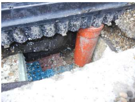
Mit keres a „felületszivargó” a hőszigetelés alatt?!
